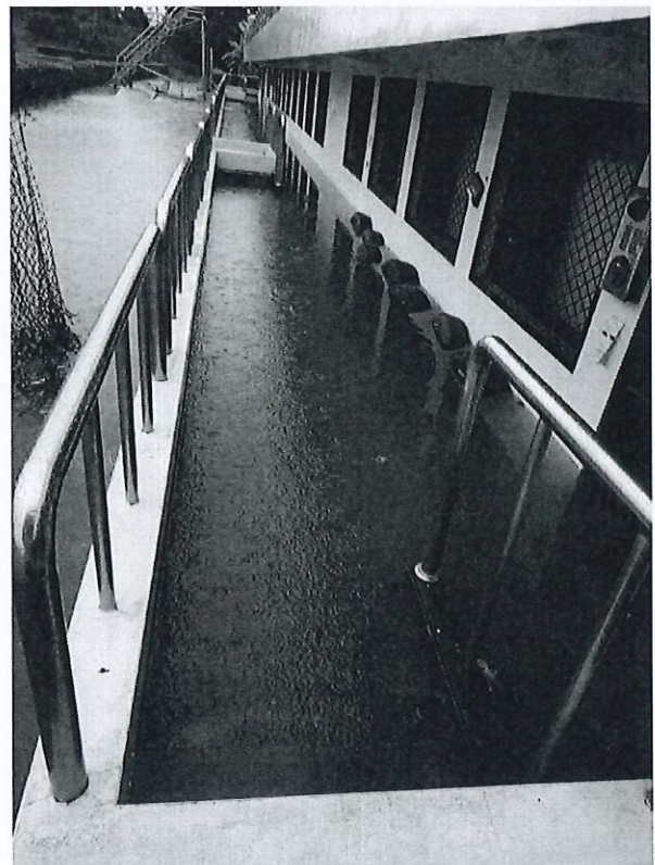
常有漏電造成危險、室內財產浸泡損壞、積水難退需大批人力清掃處理
